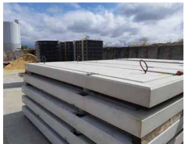
Installationsfertig: die vorgefertigten Betonsockel bei Lieferung
